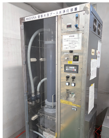
日本据点采用的水处理装置
